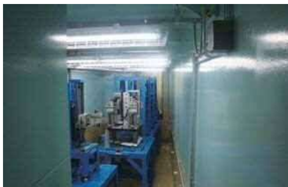
J-PARC で使用されている中性子線遮蔽コンクリート壁
