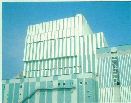
さまざまな壁材(ALC、押出成形セメント板、折板、アルミスパンデールなど)を、鉄骨ユニットに一体化。工場生産による安定品質と、現地工期の大幅な短縮を可能にしました。デザインが自由で美観の確保にも最適です。
