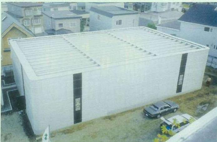
GRG遮音板とグラスウール吸音材による二重構造が、すぐれた相乗効果を発揮。騒音をシャットアウトします。材質がコンクリート系なので耐火性は完全。表面にはステンレス保護板を使用していますので、耐水耐蝕性も抜群です。また、吹付け成形をしますので、デザインが自由自在。防音壁以外にも高層ビルの外壁などに広く利用でき、都市部のさまざまな施設でご好評をいただいているます。
