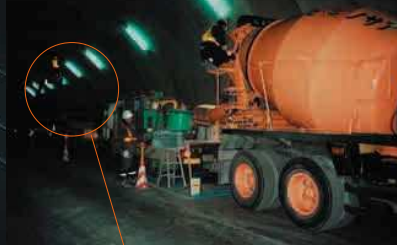
裏込め注入工
