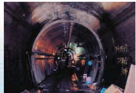
水路(補修・補強)
