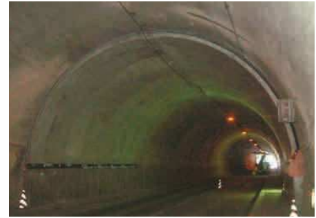
道路(補修・補強)
