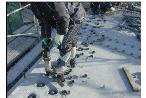
↓ アンカーボルトの本締め
