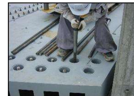
↗ アンカーボルトの挿入
