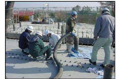
↓ 高流動コンクリート打設
