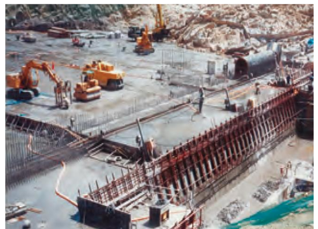
ダムコンクリート
