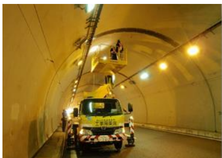
トンネル調査
