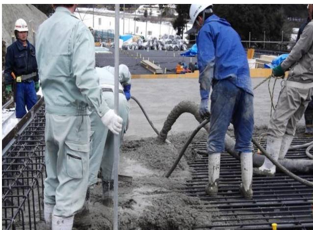
橋梁床版コンクリート
