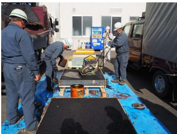
道路舗装試験体製作
