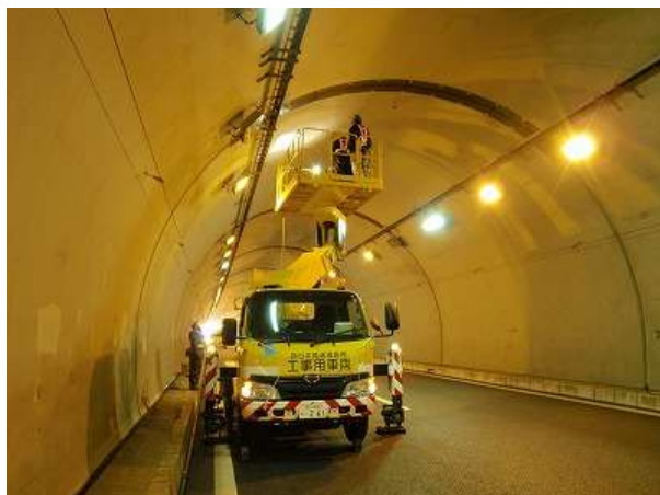
トンネル調査
