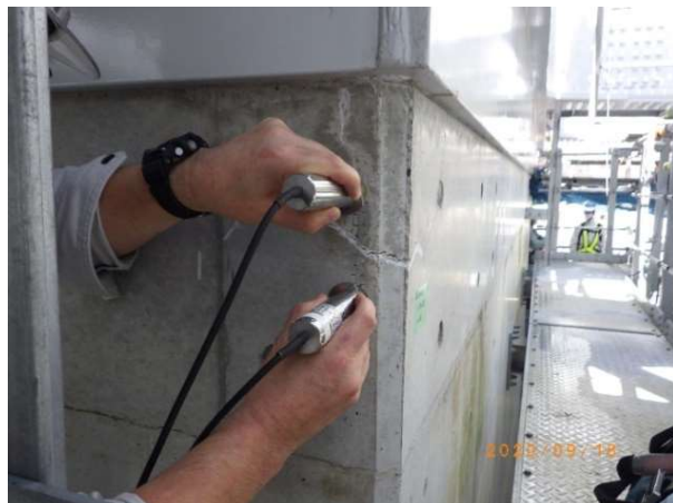
ひび割れ深さ測定
