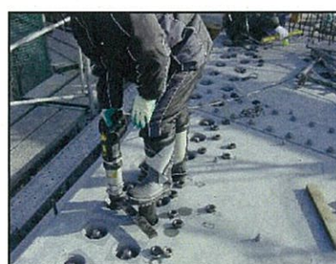
アンカーボルトの本締め
