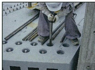
アンカーボルトの挿入
