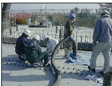
高流動コンクリートの打設
