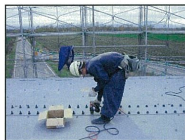
添接板の取付
