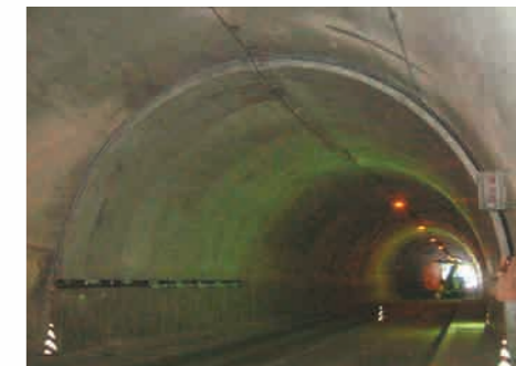
道路（補修・補強）
