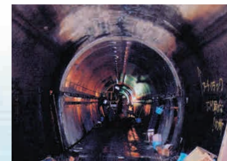
水路（補修・補強）
