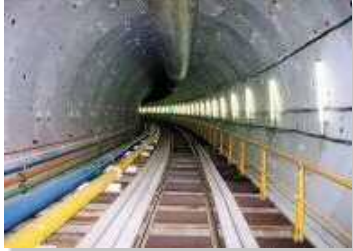
●日本鉄道建設公団 臨海、第1広町T他工事 (L=466m)
