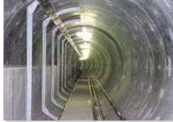
●東京電力 本牧埠頭付近管路新設工事 (L=558m)
