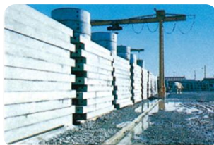
2. 製造保管状況
