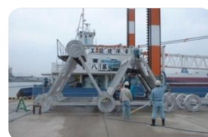
3. 組立作業状況
