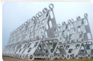
4. 組立後の状況
