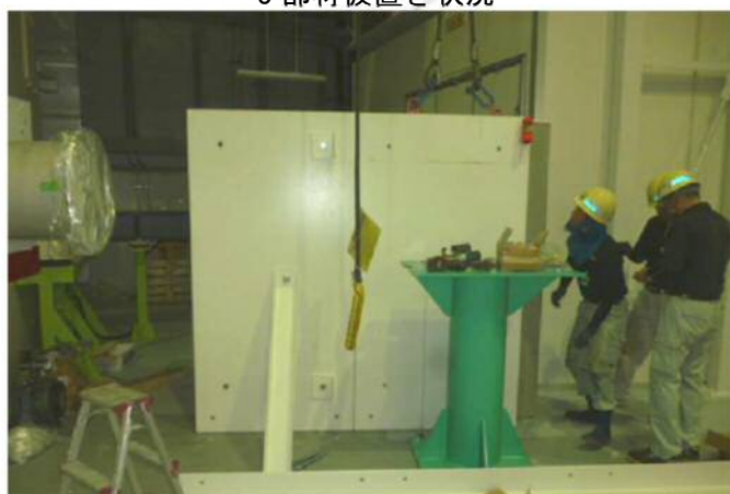
5 パネル設置状況
