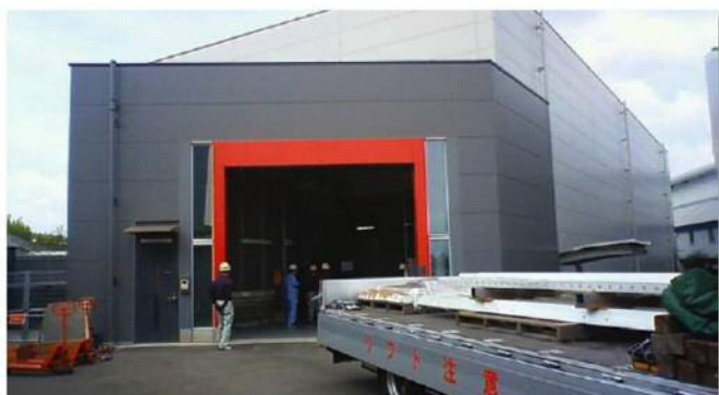
1 部材の運搬状況
