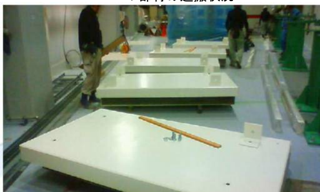
3 部材仮置き状況
