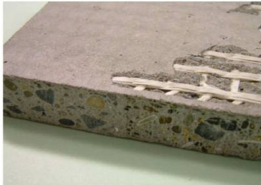
繊維シートの布設状況
