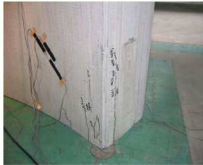
EXPセグメント端部の破壊時の状況 (ひび割れ発生後もコンクリート片は崩落しないことがわかる)
