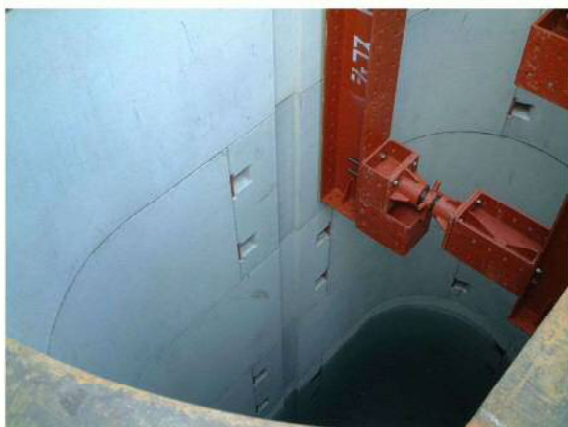
立坑への適用事例(施工中の状態、中央部支柱取り付け前)
