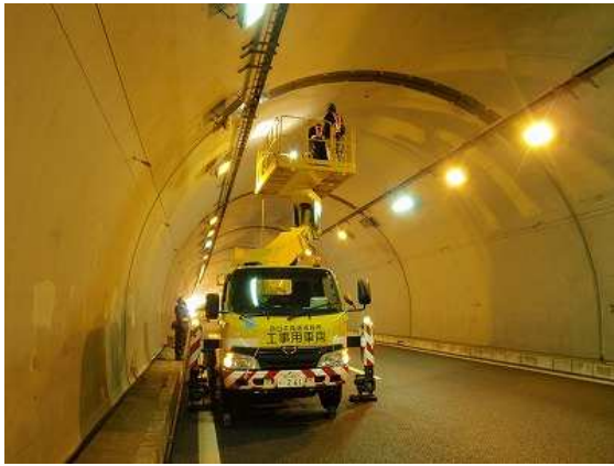
トンネル調査
